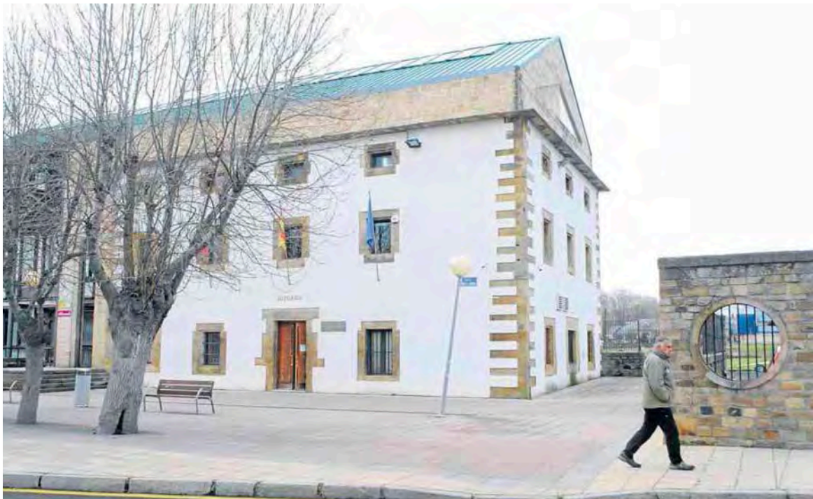
Vista exterior del Juzgado de Primera Instancia e Instrucción de Reinosa. :: B. CARBONELL
